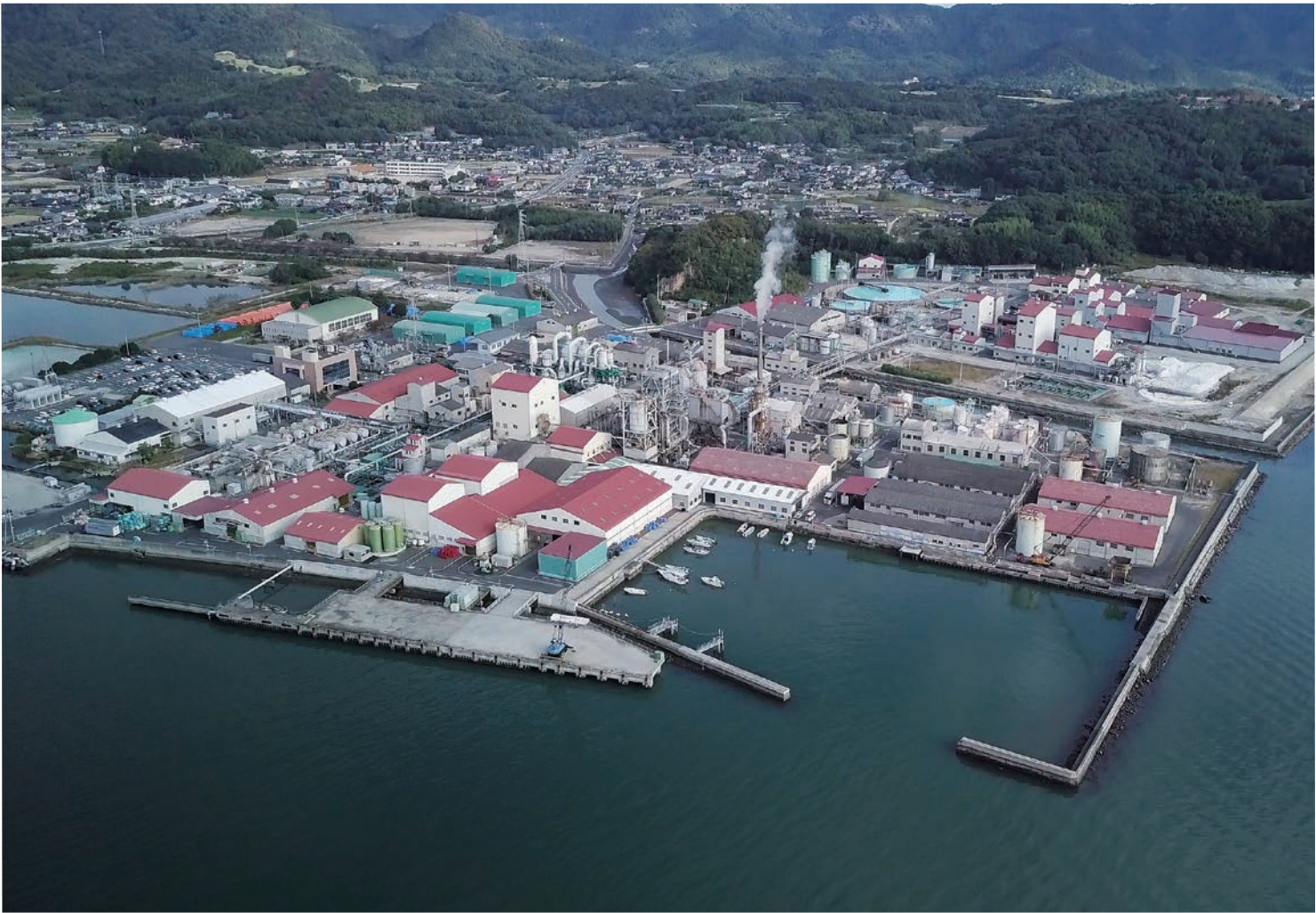
上空から見た工場全景
