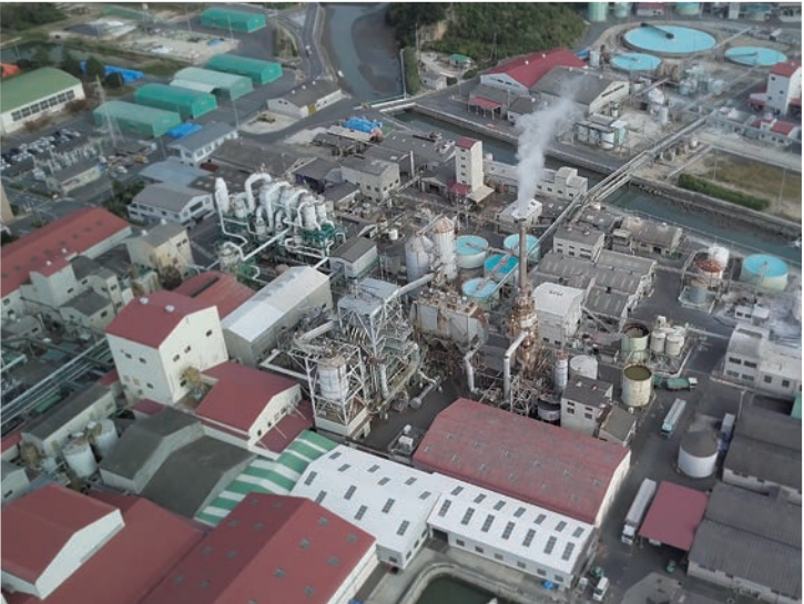
上空から見たプラント群
